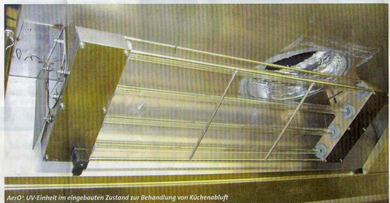
AerO ® UV-Einheit im eingebauten Zustand zur Behandlung von Küchenabluft
